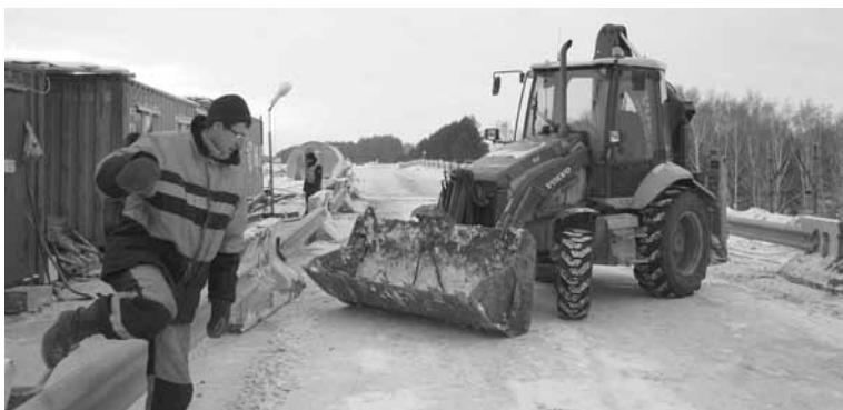
Последние рабочие моменты перед открытием дороги на Кунгур
