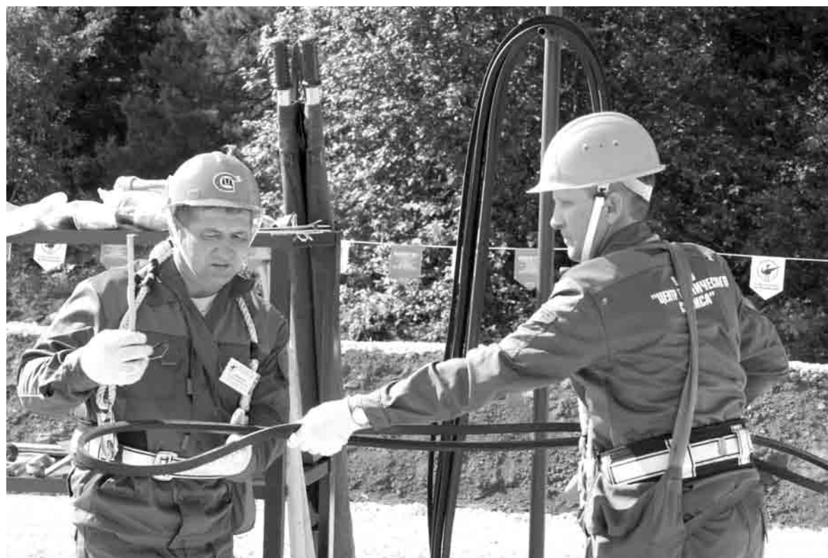
В деле - слесари по ремонту и обслуживанию оборудования
