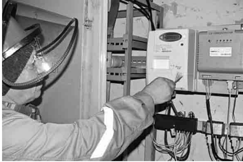
Установка электронного прибора учета электроэнергии
