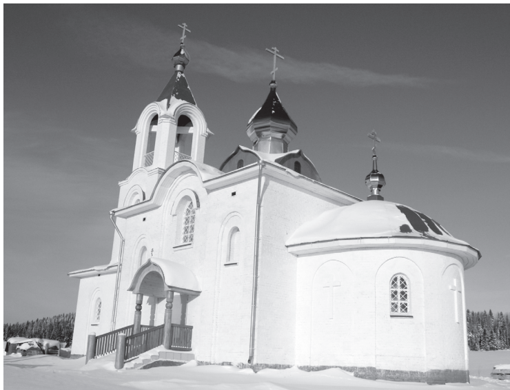
Строительство храма организовал поэт Македоний Федотовских
