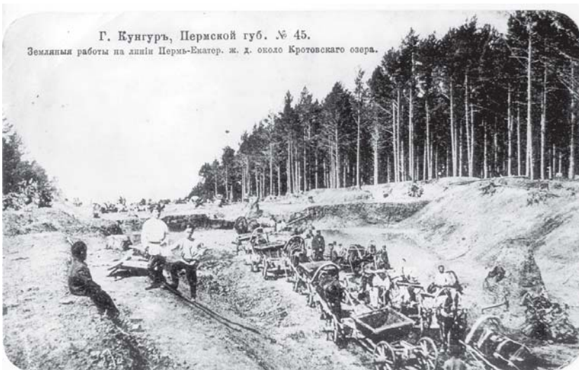
Земляные работы на линии Пермь-Екатеринбург
