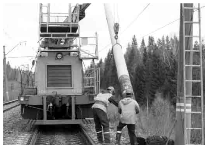
Установка опоры контактной сети с автомотрисы
