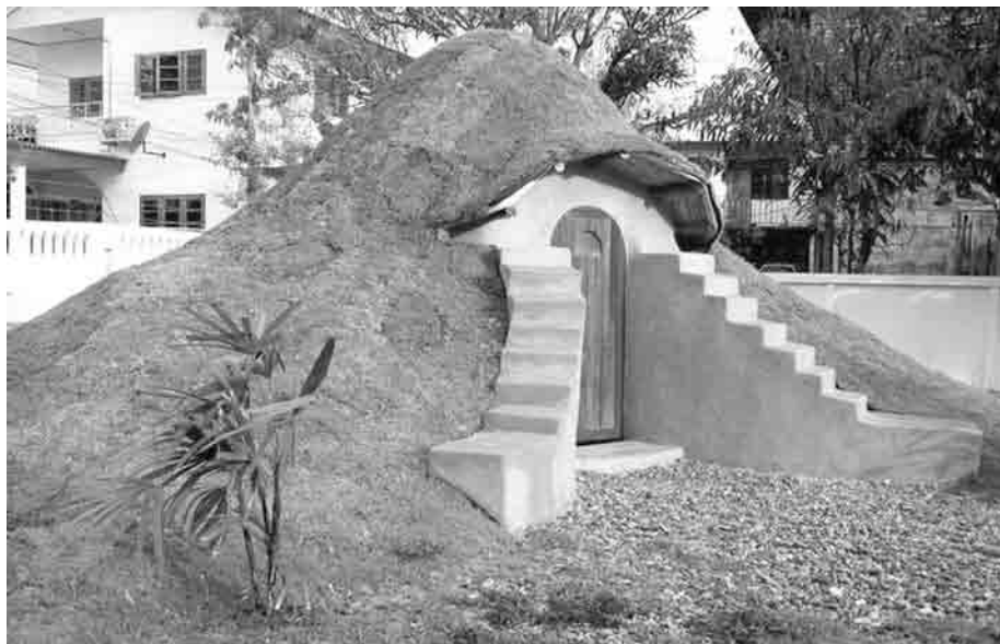
Наземный погреб с обваловкой (внешний вид)
