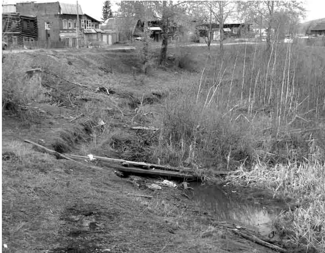
Берега обвалились, когда вода из озера ушла под землю
